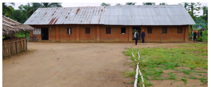
増築中の病院（右側が増築部）
