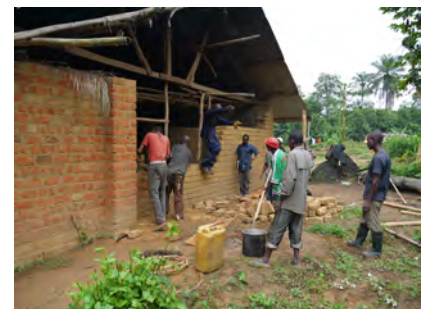
病院の増築工事の様子
